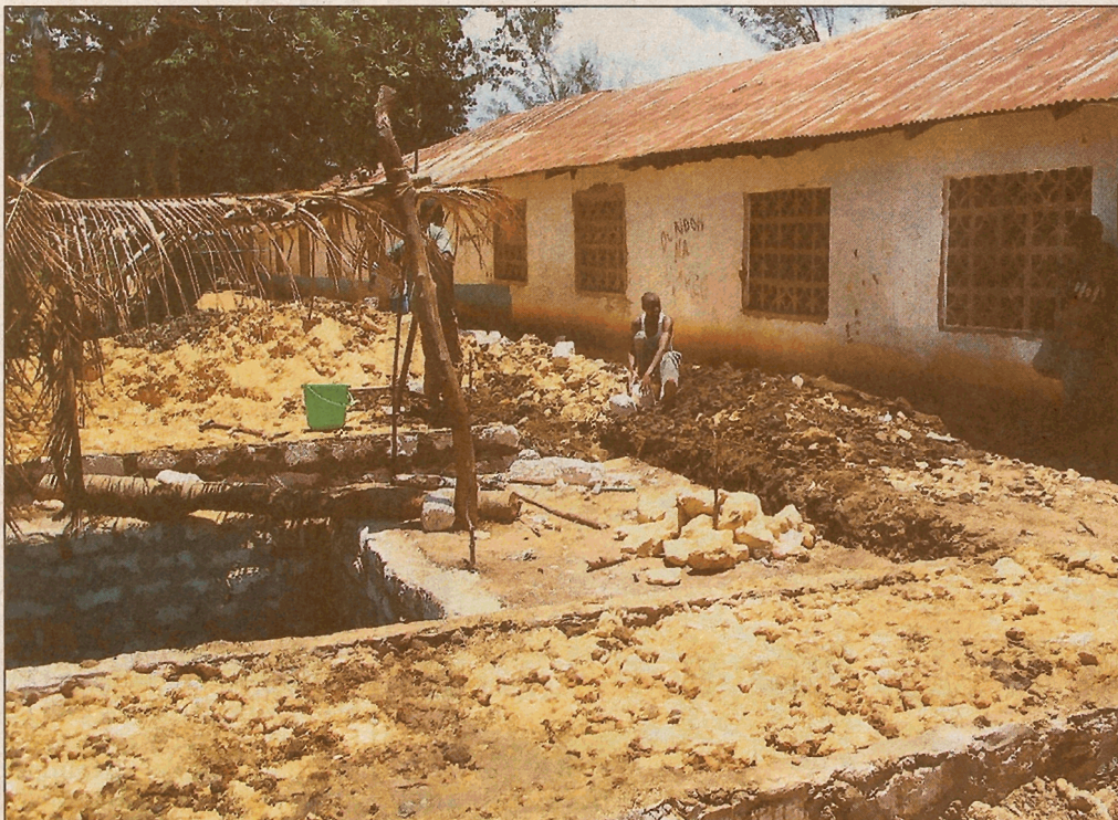
Der Mitarbeiter des Vereins in Ukunda, Masoud Omar Vumbi, hat jetzt Bilder von den ersten Arbeiten für die neuen Toilettenanlagen gesendet. Die rund 13 Meter tiefe Fäkaliengrube ist ausgehoben. Um sie herum sollen die drei Toiletten-Häuschen entstehen. ■ Foto: pr
